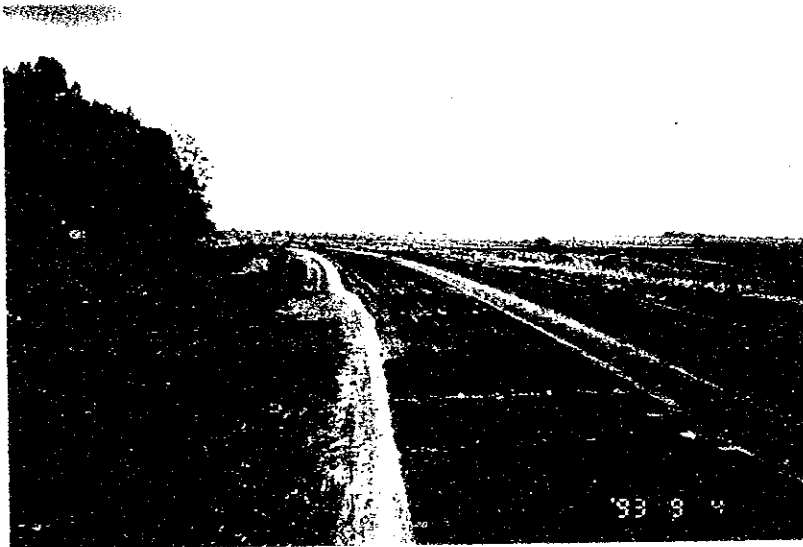
A 2 号線 Thika ~ Kabati 間 道路新設工事区間
