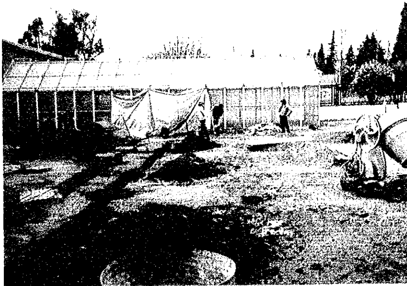
IFFIVE建物増築工事（基礎工事）
