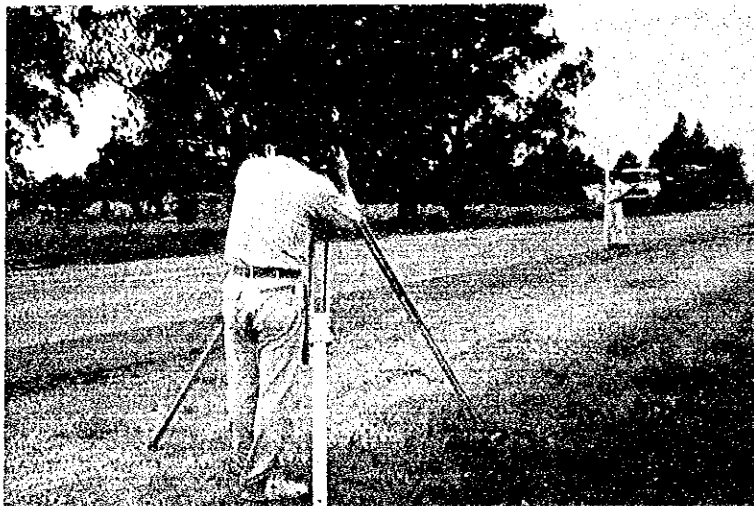
標高の点検測量
