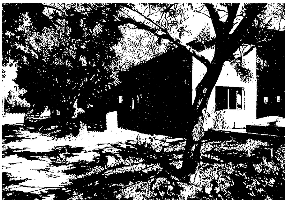
INTI エネルギー部旧建物（建て直し予定）
