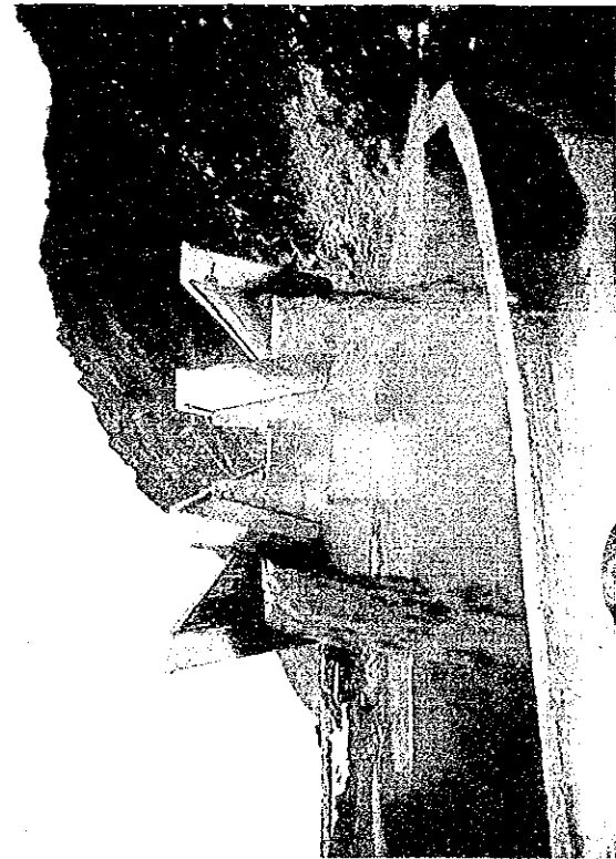
灰スラリー橋 の終端部の 暗渠で右図の 流下口に連結 されている
