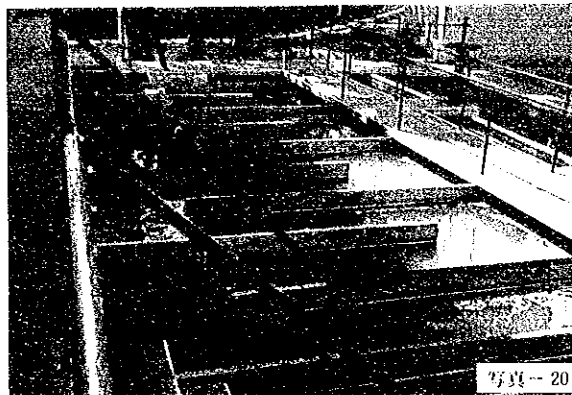
凝集池 フロックの形成が極端に少ない。
