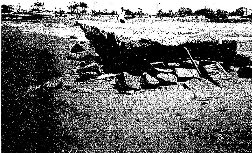
写真-4 防砂堤（北側）…………… 先端側より 防砂堤基部の捨石が、わずかに確認できる。
