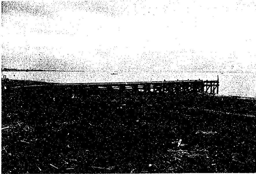
写真-7 木製栈橋 ……… 北側より 完成当時（1988年）には確保されていた水深も現在は皆無の 状態である。
