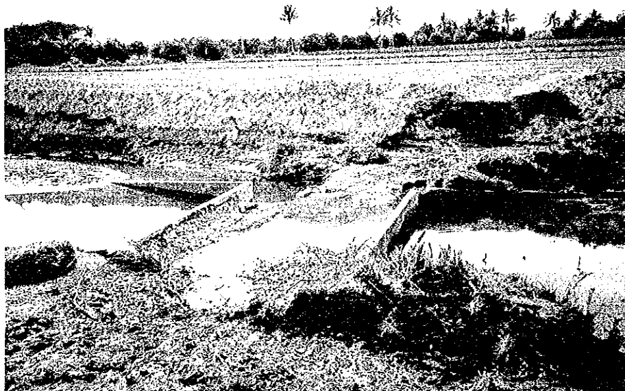
写真-6 グマイン川灌漑開発計画の対象地域内における灌漑用水路構造物のラハールによる埋没状況 (撮影日:1994年1月13日,グマイン川右岸側の農業用水路)
