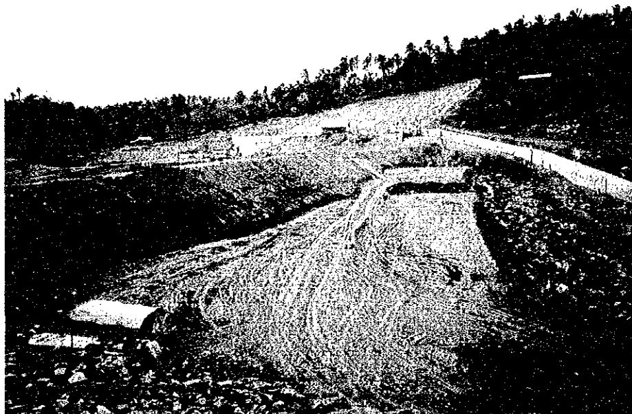
写真-10 タグム・アングスダム堤体の台風襲来後の修復作業 [ダム下流側(写真左側)ランダムゾーン2000㎡以上の盛土崩壊・流失後の修復] (撮影日:1994年1月17日, ダム余水吐地点より右岸部をのぞむ)
