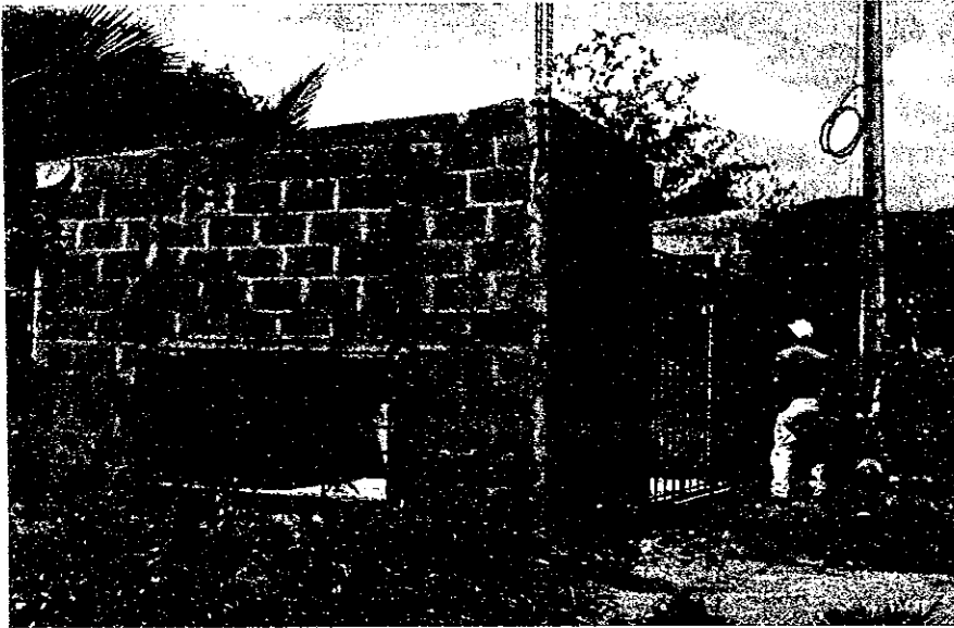
写真 7 建設中のポンプ小屋 MAGA-USAIDの小規模 地下水灌漑事業地区
