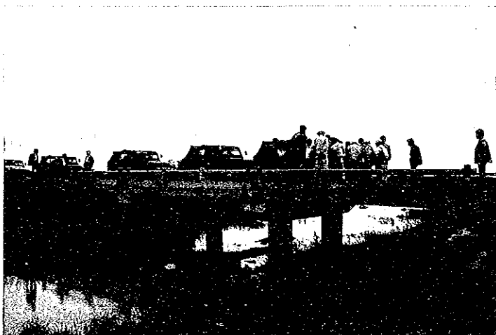
虎北排水路に架かる橋
