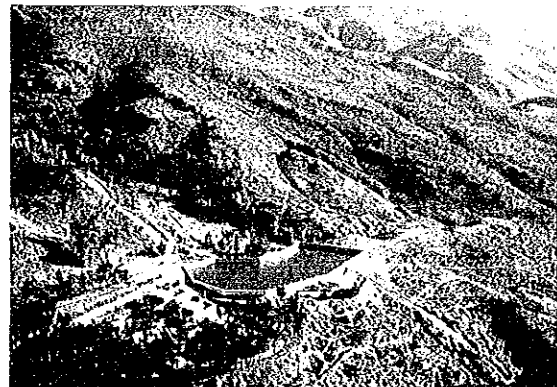
サン・ホセ川上流チャピキーニャ発電所下池、ラウカ川より導水しサン・ホセ川に流している
