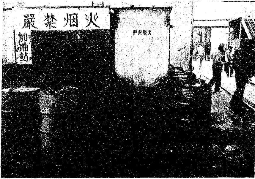
図Ⅲ-1-8-02 使用されていない油沈殿タンク
