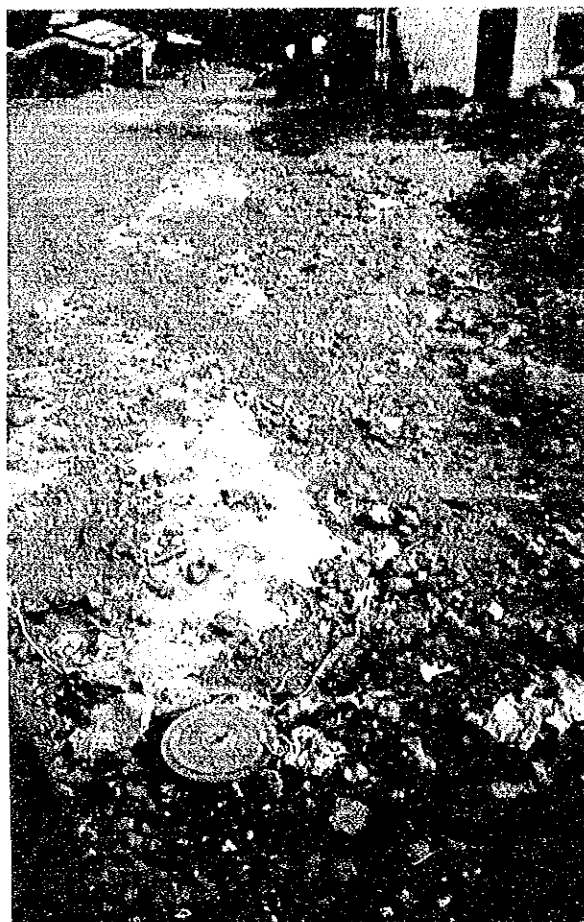
De la salle de vannes de détente vers la Route Nationale Réparation des excavations des travaux de la Phase I, en béton revêtu en pierre
