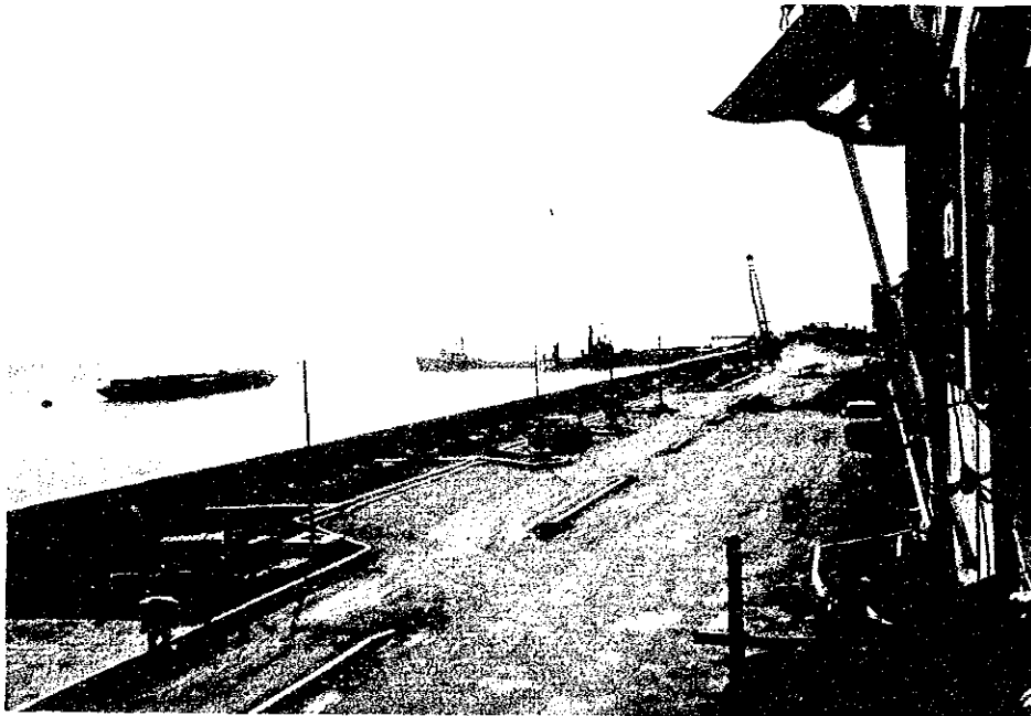
ロゾー護岸工事（計画予定地に隣接）
