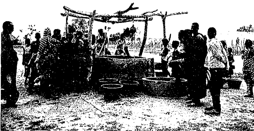
コンクリート製浅井戸 人力揚水タイプ M' BAGNE 県 Garalol 地下水位 22m
