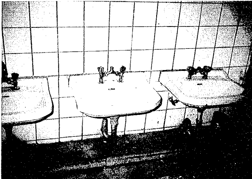
取手がねじきれたため使用されていない洗面所
