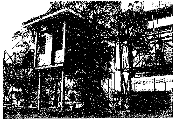
高床式の測定局舎
