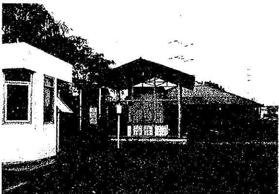
EMC からジャカルタ特別市へ移管された測定局舎 (Pulo Gadung 工業団地内)
