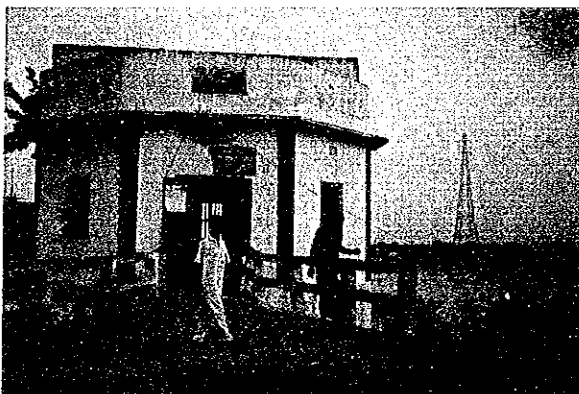
CHANDNIGHAT浄水場の取水ポンプ場(BURIGNAGA川) イギリスの植民地時代に建設されたもの。このポンプ場からCHANDNIGHAT浄水場へ圧送される。
