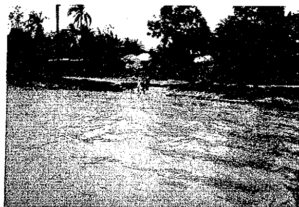
JAMUNA川左岸(ARICHA村付近) の川岸洗掘状況
