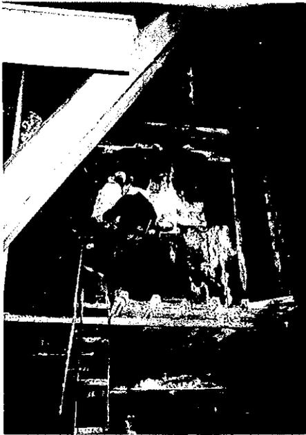
写真-30 マラヤ発電所1号機ボイラー、ガスリーク箇所
