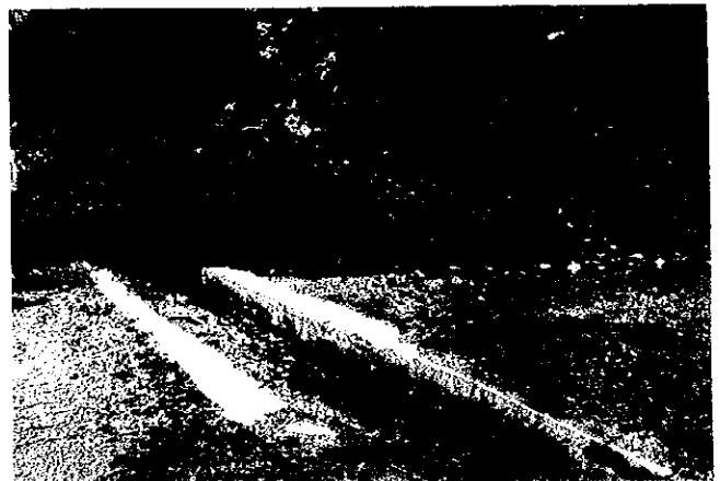
幹線水路と、小沢の交差点。洪水時には、沢水と共に多くの土砂が水路に流れ込む。
