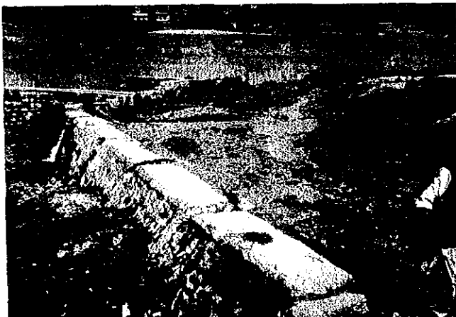
No.2 取水堰 手前のパイプは、湧水を水源とする上水供給用
