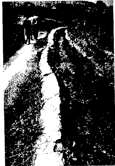
崩壊している水路 予算不足のため補修は見送られている。
