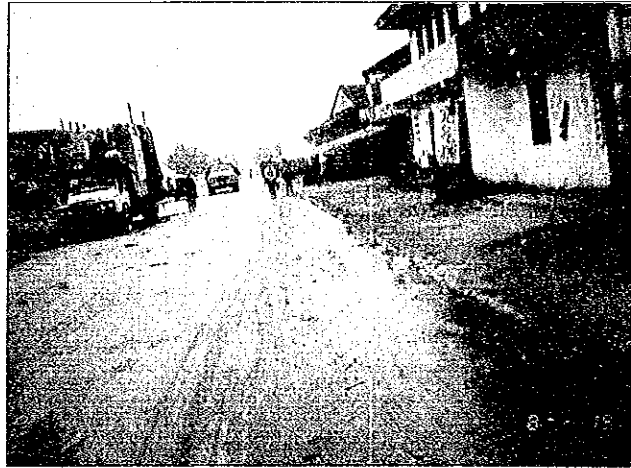
町中を通過する部分もほぼ同じ幅員であるので、交通の障害になる場合が多い。
