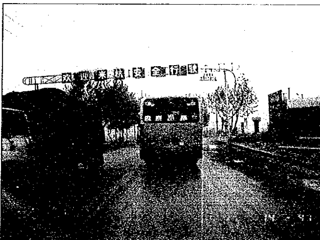
上海市から西に進んで浙江省内に入り、嘉興市を通り杭州までは概ね国道320号のルートである。現況は概ね2車線道路で、交通はトラック類が多く、フルトレーラーも見られる。路面はコンクリート舗装またはアスファルト簡易舗装である。
