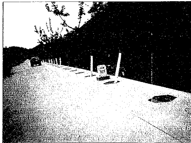
改良してコンクリート舗装が新しい区間も見掛けられる。
