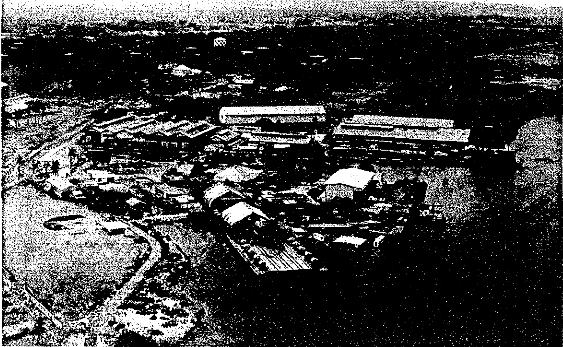
Figura 5-4-4 Facilidades Reparación de Naves
