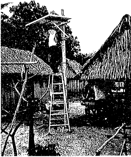
PVパネルからの配線取付 北タラワにて (1993年1月)
