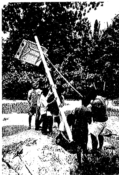
PVパネルをとりつけた ポールを建てる 北タラワにて (1993年1月)
