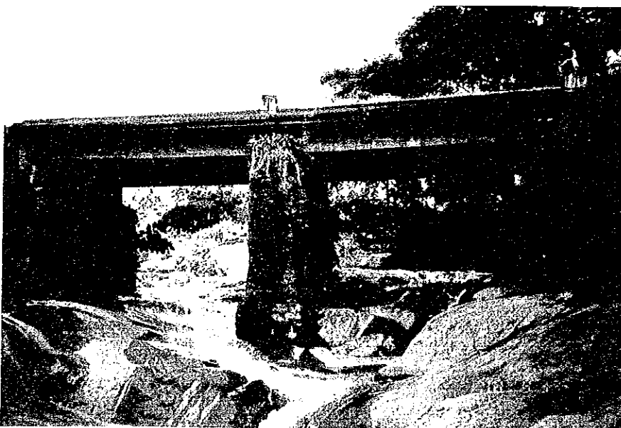
小河川を跨ぐ国道2号の橋 (DAMARA南方) H鋼の桁が入っており、 大型車の通行は可 河道部は黒雲母石英片岩の 露頭
