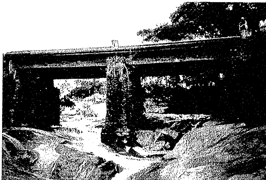
Pont sur la route nationale 2. (Sud de DAMARA). Passage possible des camions grâce aux profilés en H Affleurement de schistes, quartzites et biotites vers la rivière
