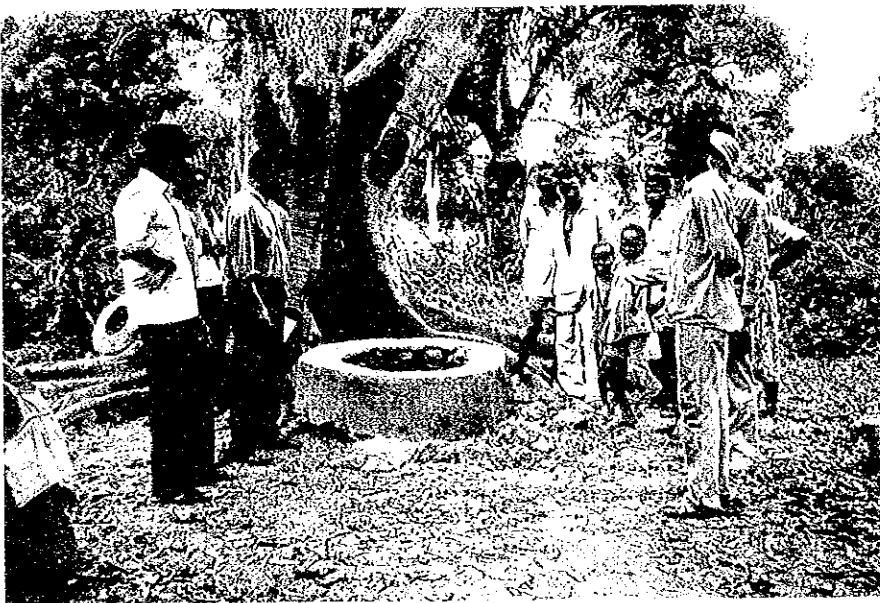
Puits creusés à la main BOBASSA I s/p BIMBO
