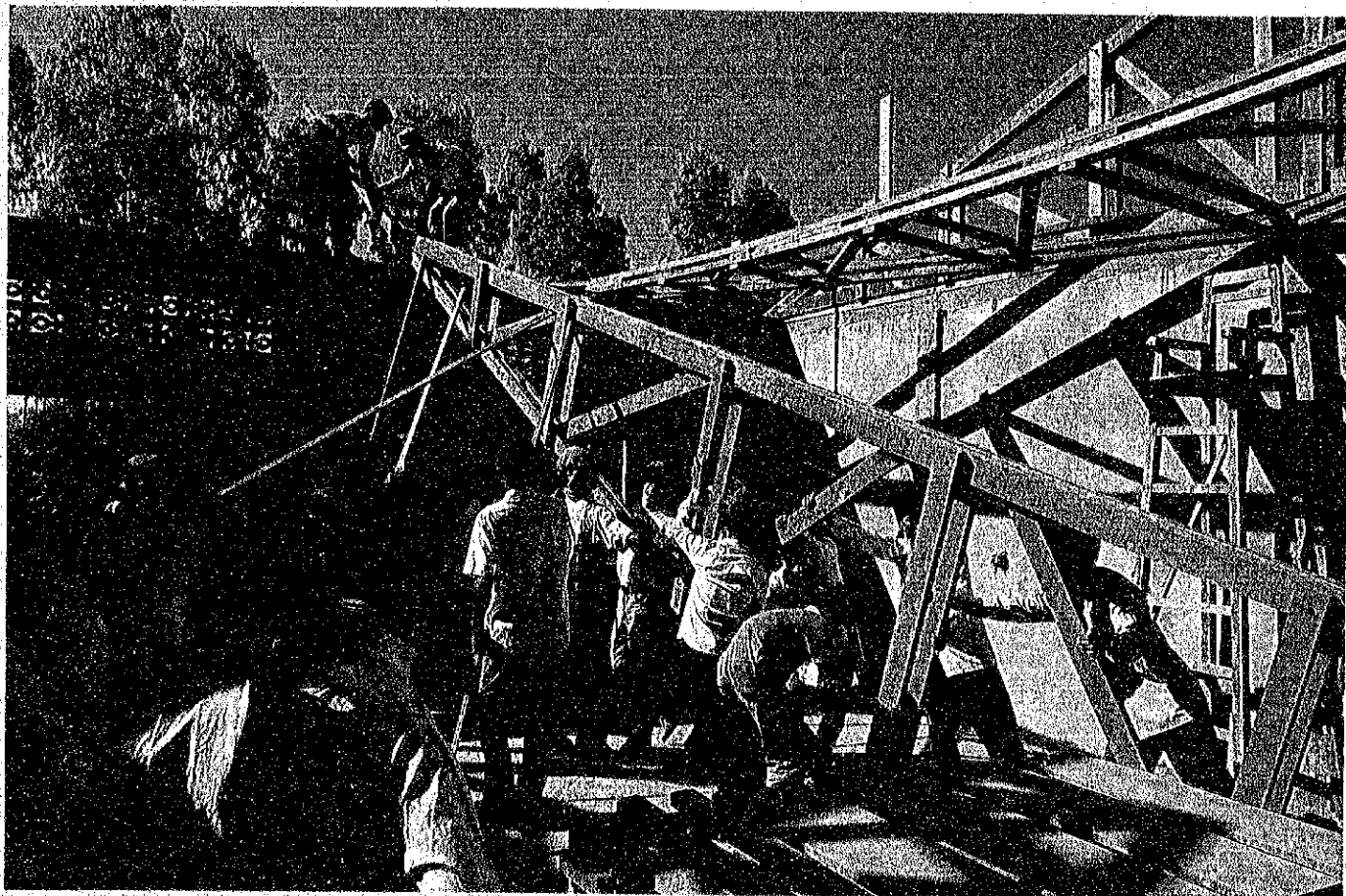
技術科教師の原口明久隊員は学校建設・修理のプログラムに参加。学校の先生、生徒ら地元の人々の手で自ら学ぶ学校の校舎造りが進んでいる。
