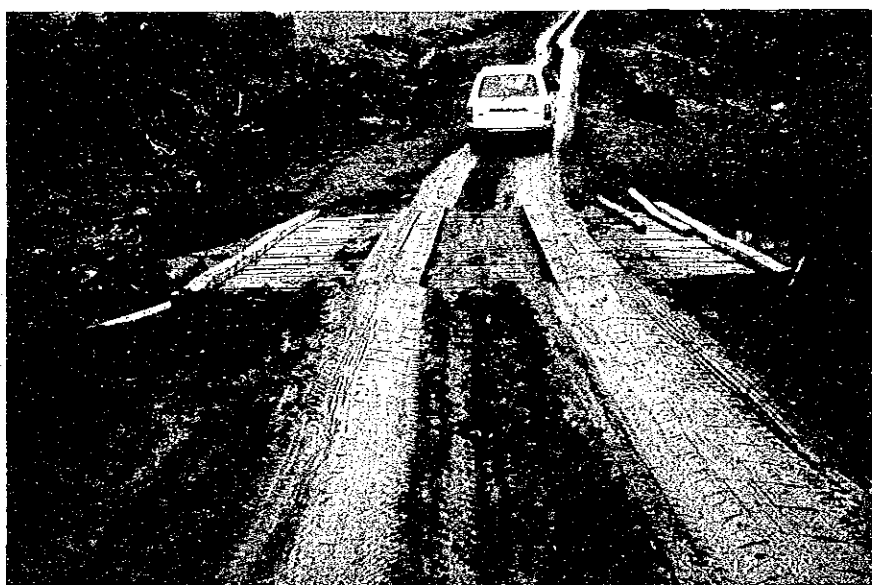
橋梁 No. 5 - 2 正面
