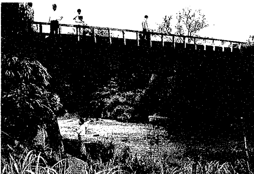
橋梁 No. 1 - 6 側面
