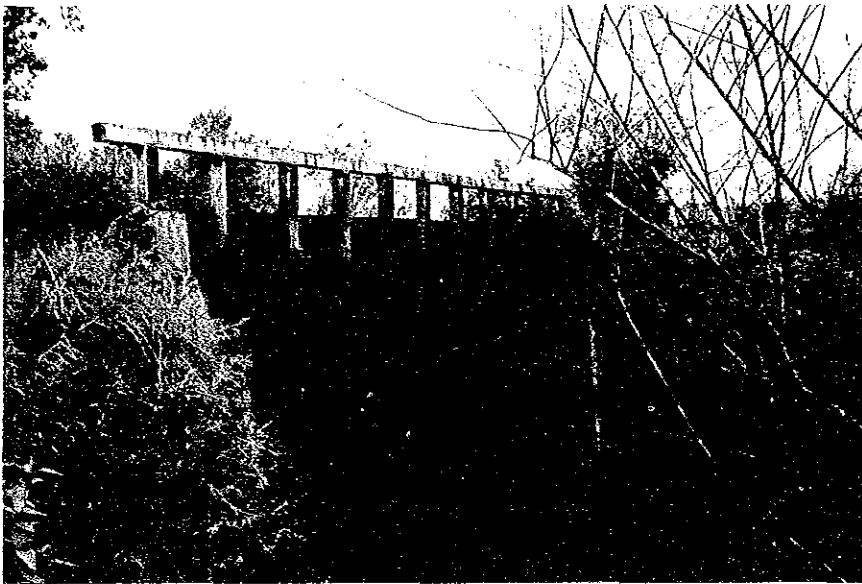
橋梁 No. 1 - 4 側面
