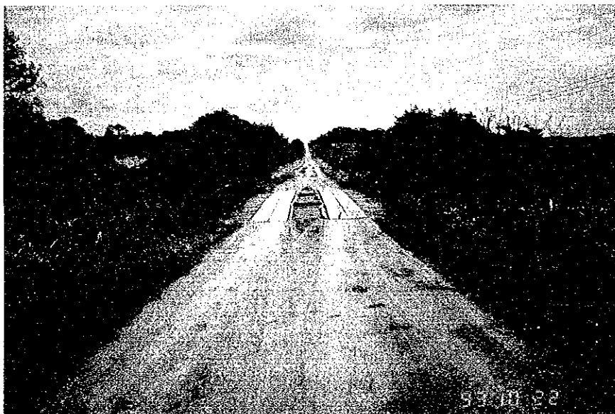
Puente Existente No. 1-6
