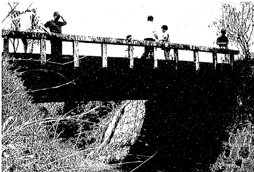
Puente Existente No. 1-5
