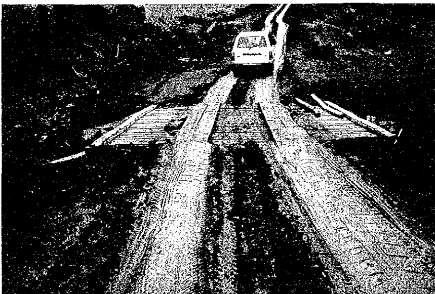
Puente Existente No. 5-2
