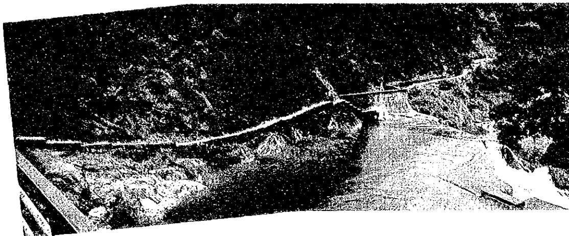
同地区の幹線水路、土砂の堆積著しい
