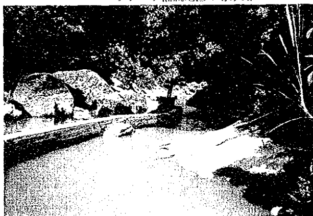
ダメエラ灌漑地区の導水路
