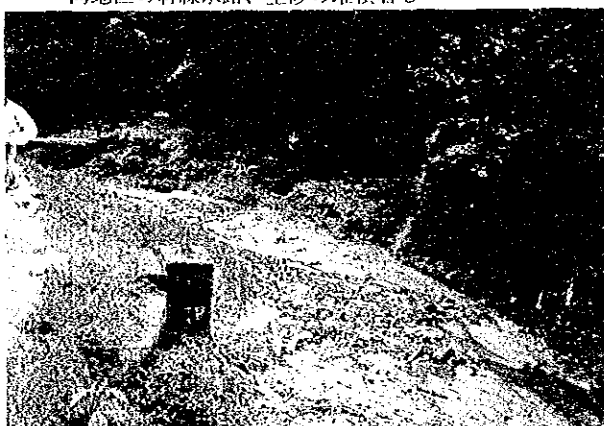
同地区の幹線水路、土砂の堆積著しい
