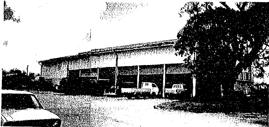
修理工場全景
