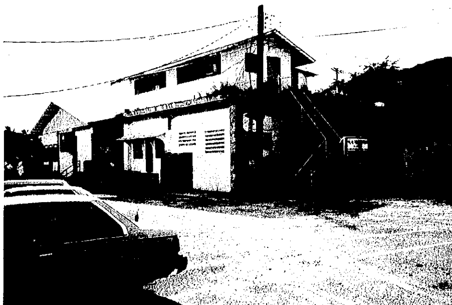
写真6 コロール州マラカル地区にあるパラオ漁業協同組合連合会の建物。1階右より倉庫、整備工場、事務所、冷蔵庫。
