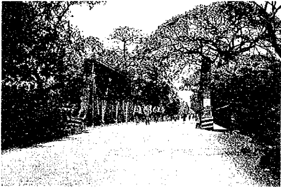
橋梁 (RN 6、シエムリアップ市西方)
