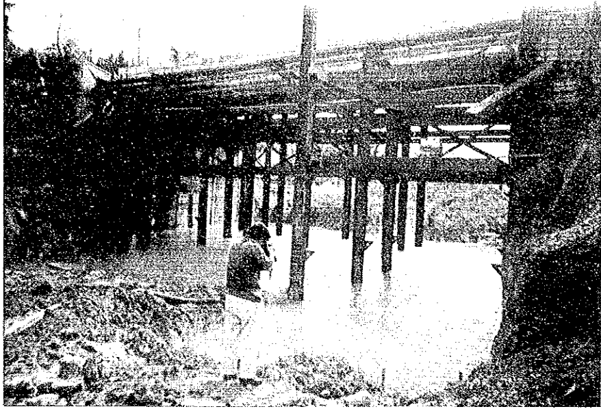
スリランカ港拡充工事現場視察風景
