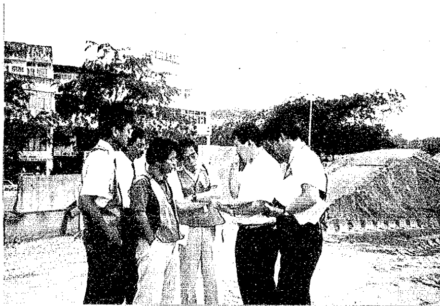
マレーシアに於ける南北縦貫道工事現場視察風景
