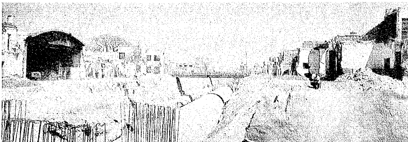
平成5年3月19日(金)下水道爆発事故復旧現場
