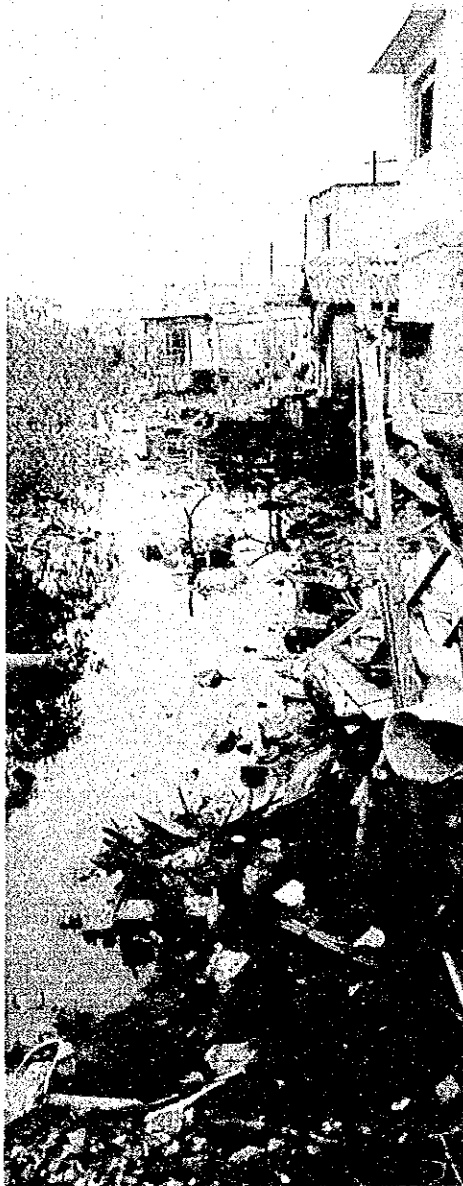
写真左：サントス市商業地区
