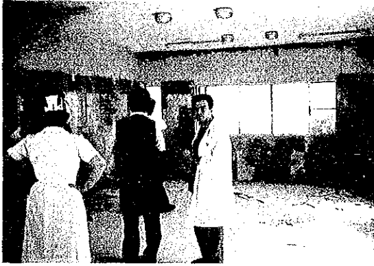
ラタキア州 アルワタニ病院救急部門改修工事現場
