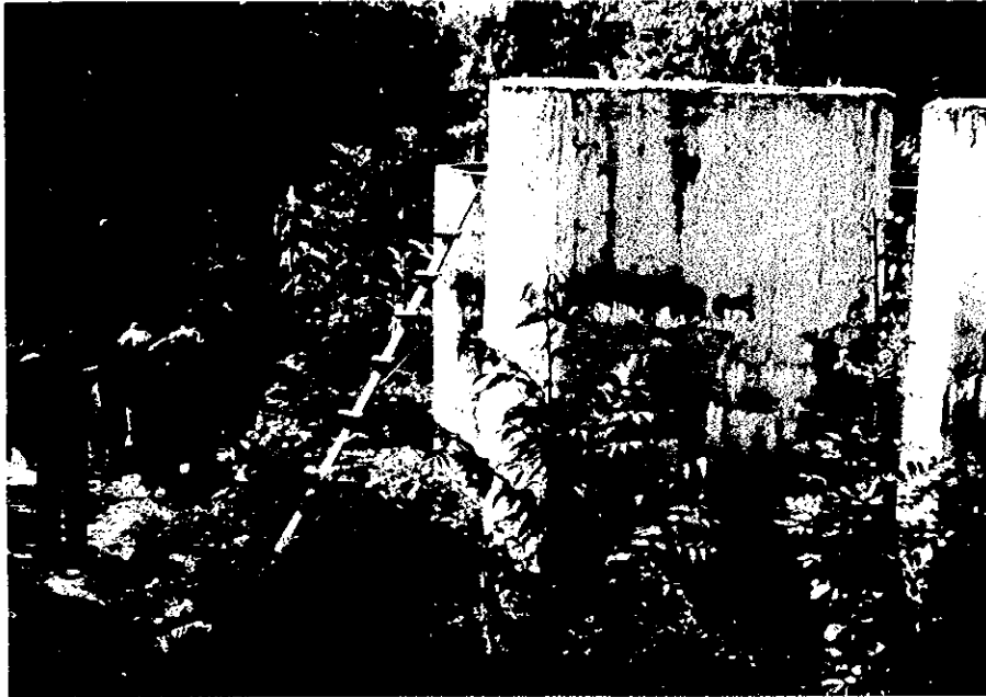
1. チェンライ県・ヤオメタム村の生活用水のタンク。ユニセフの援助（8年前に、水道設置事業費55千バーツのうち37千バーツを支援）で造られ、3 km先の山（水源）から幹線パイプ（外径50mm）でタンクに導水し、村の民族別に2分して配水（外径25mm）、末端の給水は、外径20mmのパイプ。
