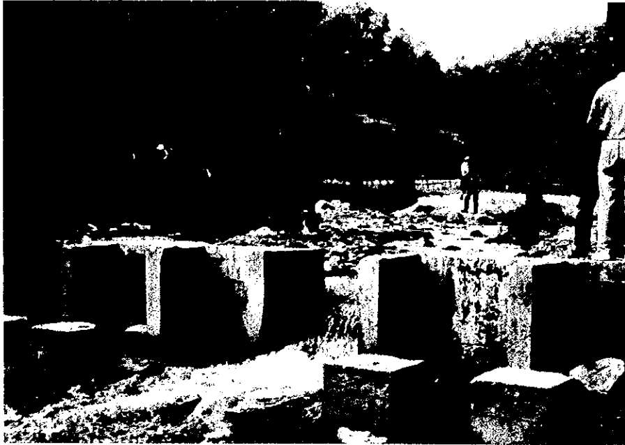
3. チェンマイ県・クンサーブ克蘭村に施設されたコンクリート堰。 延長10m、高さ1.5 m、幅94cm、壁厚21cm。予算25万バーツで、県が 負担、設計し、村人が労働して20日をかけて完成。水田に灌漑。 (詳細は、本文参照)
