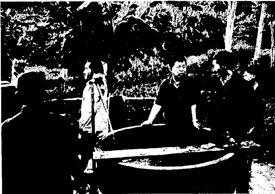
14. トンナムアン村の生活用水の貯水施設。山の中腹の湧水から引いてくるが、低地部に給水できるが、高地部には及ばない。予算不足、プロジェクトとしての取り上げ方の未熟さが原因とのこと。
