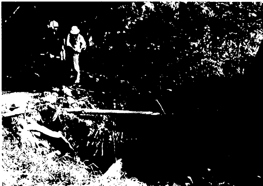
2. チェンライ県・クンファイメパオ村のふくろ堰。3.2 haを灌漑。延長8 m（ただし川幅6 m）、幅約2 m。下流側での落差は1.3 m。上流側は堆砂して、30cmの深さ。15年前に、タイ人の指導で施設し、毎年修復している。（本文参照）
