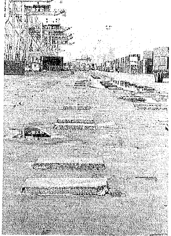
④ クロントイ港(バンコク港にて) (1) 帰国研修員らと (2) コンクリートの柱が床を支え切れずにはみ出しているもの
