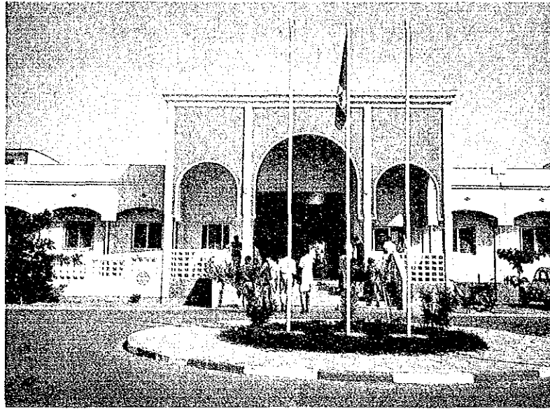
Hall de l'Hôpital Régional de Kaolack
