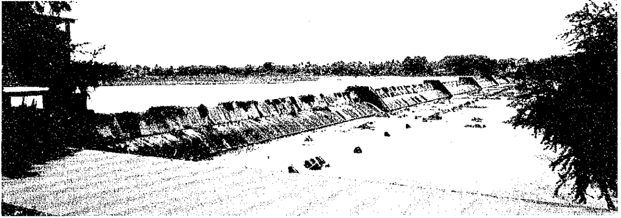
▲ ブストス頭首工
