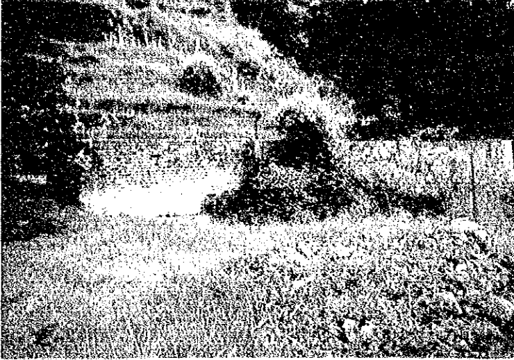
キルティプールセンター周囲の堀 (色の異なる部分が、かさ上げした部分、 さらにその上に有刺鉄線を設置した)
