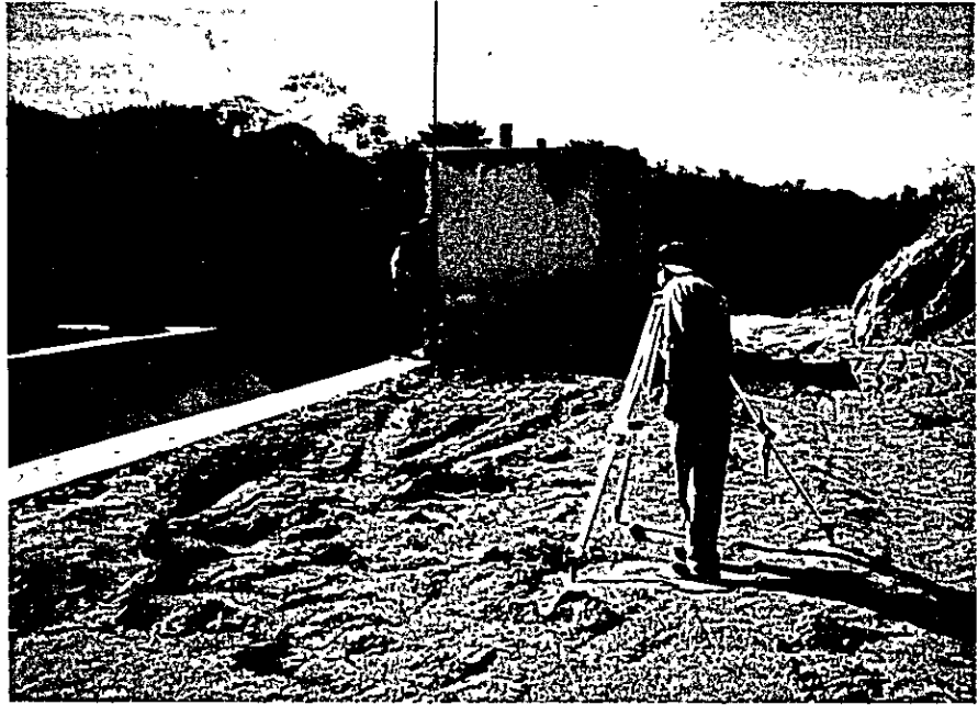
流路工天端高の検査
