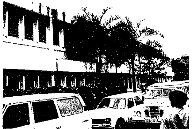
4. タンザニア森林研究所 (TAFORI) 本館 (モロゴロ市)
