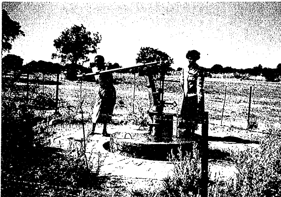
ポンプ付浅井戸 (手掘り掘削、必要に応じて発破掘削にて掘下げ)
