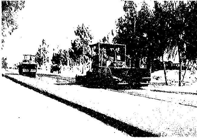
道路改良工事の状況／N-5 (Rawalpindi～Peshawar)
