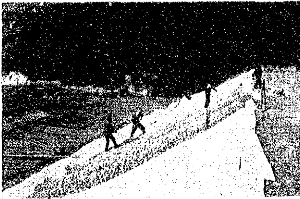
ทำพนังกั้นดินที่ กม. 14+500
