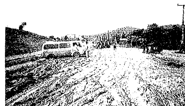
写真5.2.2-24: 109号、建設途中でタイヤがスリップして 立ち往生した車両
