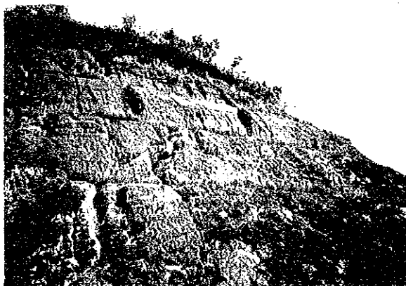
写真5.2.2-15: 1149号の古い切り土のり面侵食
