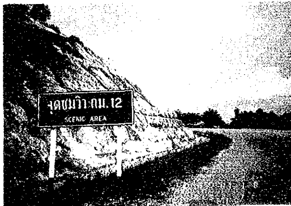
写真5.3-2 : 1149号、コンクリート吹き付け工
