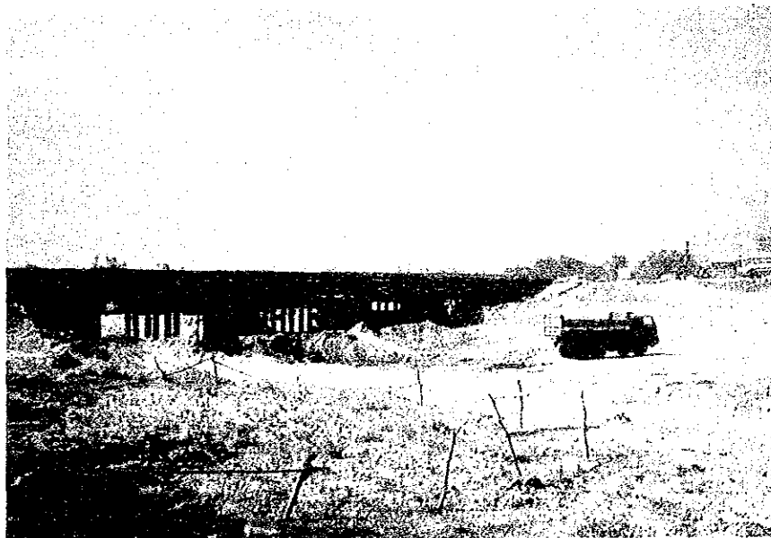
▲ 泥流で河床の上昇した河川 (乾期中に土砂を移動し、流水路を確保しようとしている)
