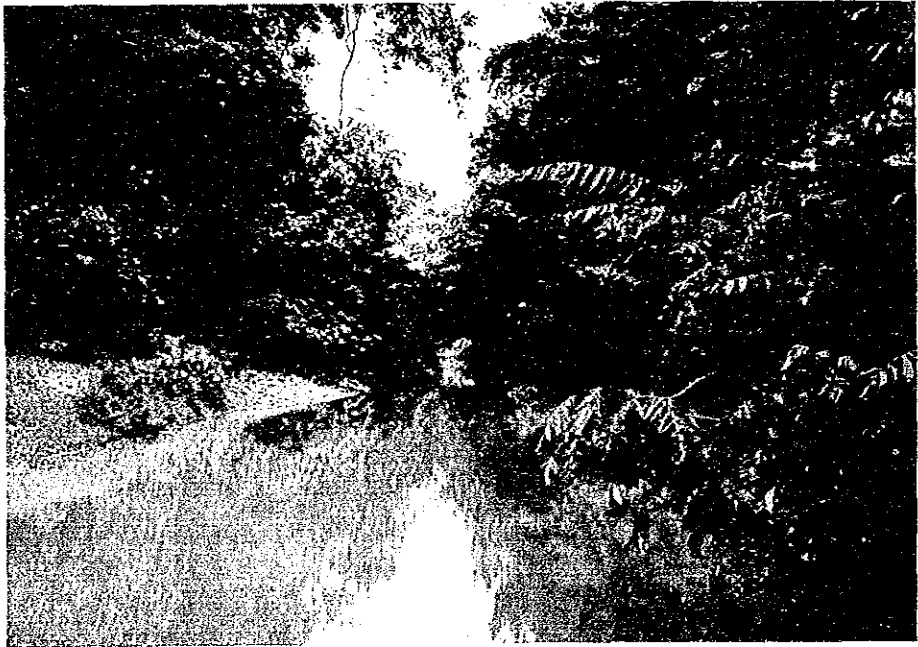
写真 2. ホワイ・バック上流ダムサイト付近現況 (ホワイ・バック)
