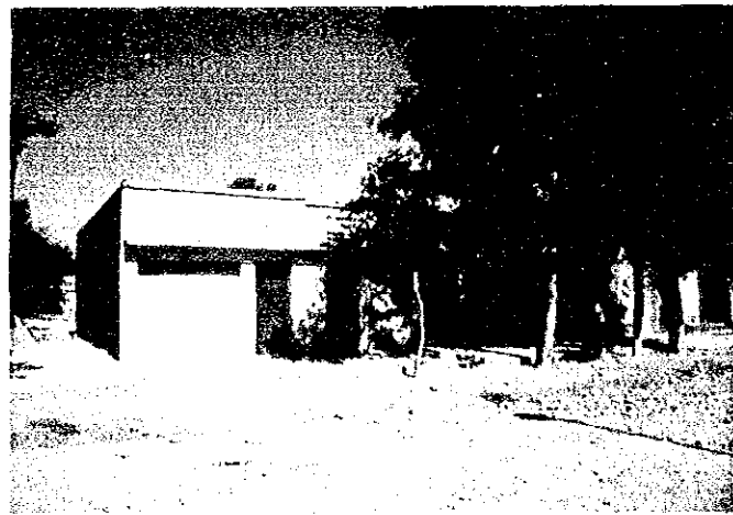
▲ カウンターパート機関が作業事務所に予定している建物（インヘニロ・フォアレス）
