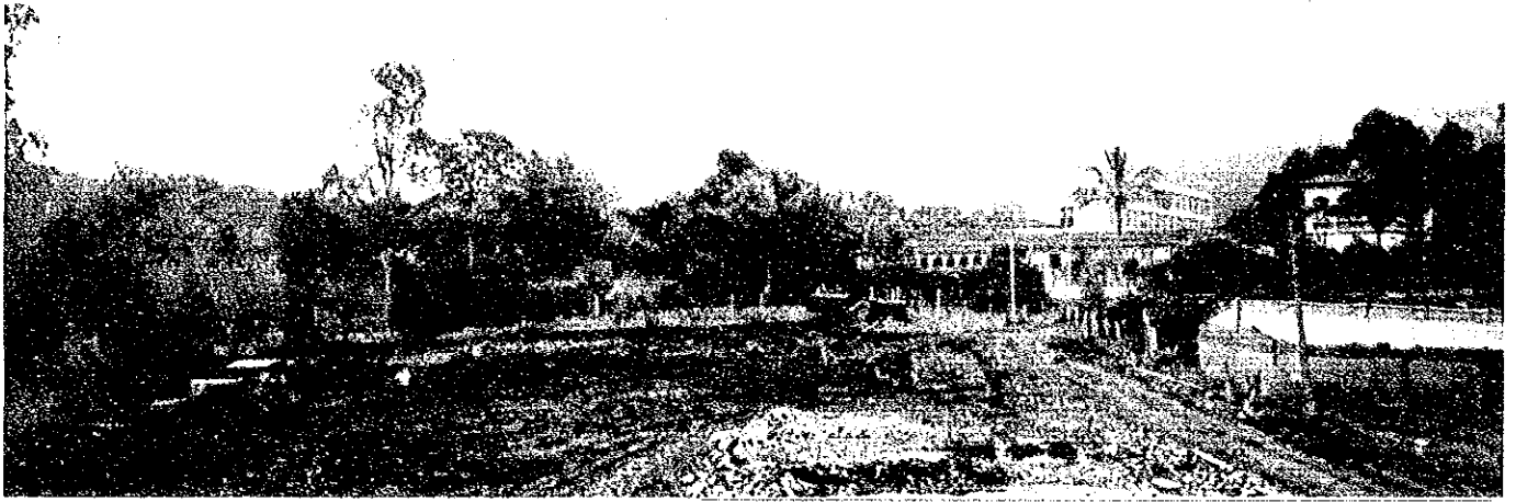
▲ CECILプロジェクト建物建設現場（整地工事中）
