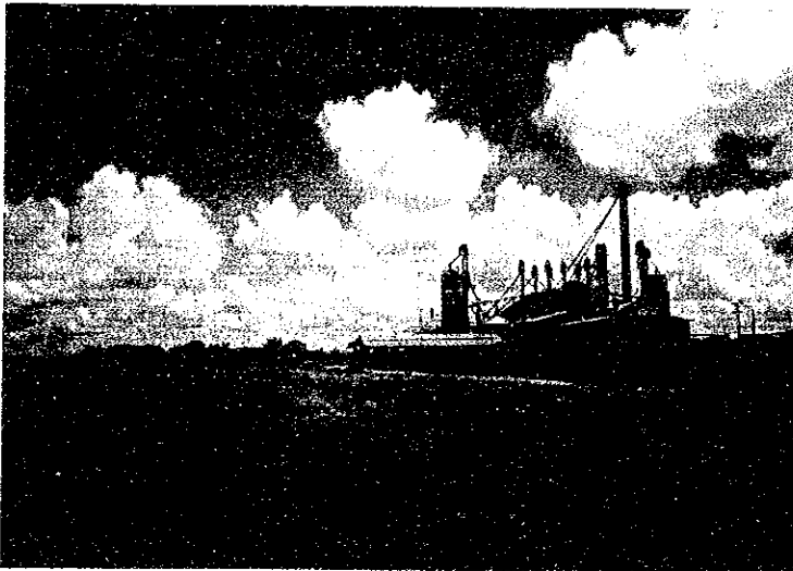
セラード内穀類貯蔵施設
